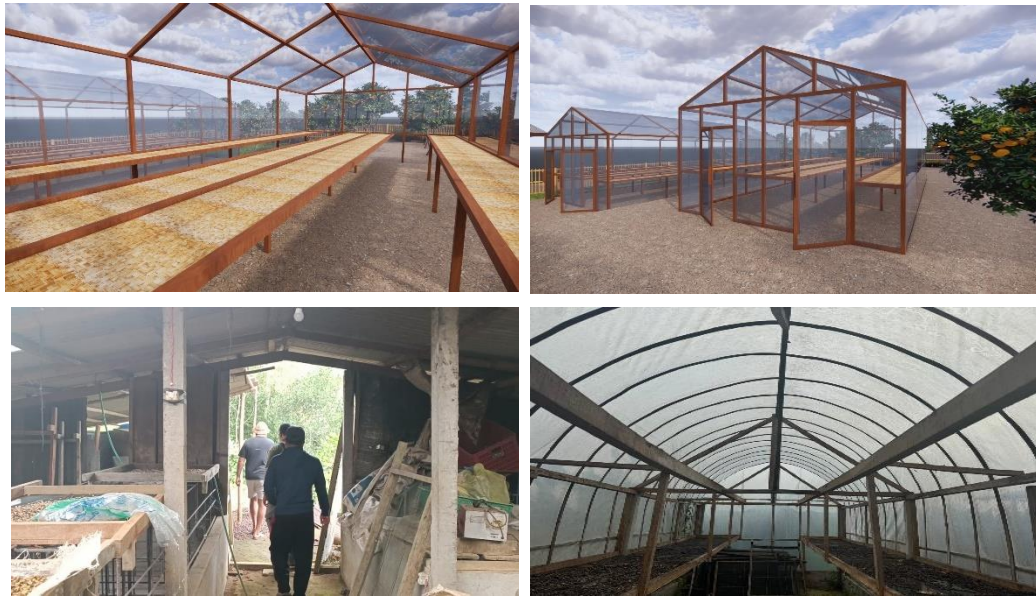
Gambar 8: Konsep design Solar dryer dan progres pembangunan
